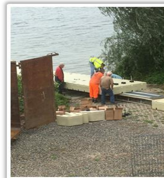
Die ersten Montageschritte
